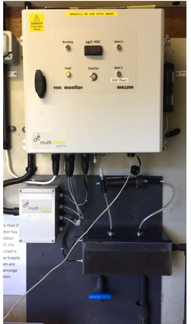
Resim 16 - Ek binada kurulu ünitenin bir resmi. Ünite, kirlenme durumunda akışı rezervuardan uzaklaştıran bir savak kapısını kontrol eder.
